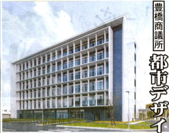
シンフォニアテクノロジー豊橋製作所技術開発センター（三弥町元屋敷）
